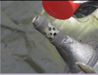
PARAFULMINE (PARTICOLARE) Foto di: ARPA Friuli Venezia Giulia Radionuclide: Am-241 Provenienza:
