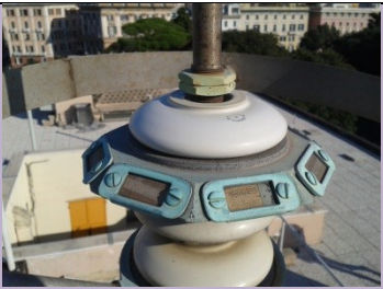
PARAFULMINE SAREF-DONELLI Foto di: ARPA Liguria Radionuclide: Ra-226 Provenienza:
