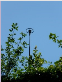
PARAFULMINE SAREF-DONELLI Foto di: ARPA Liguria Radionuclide: Ra-226 Provenienza:
