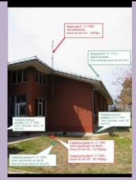
PARAFULMINE (VERIFICHE PER SMANTELLAMENTO) Foto di: ARPA Valle d'Aosta Radionuclide: Am-241 Provenienza:
