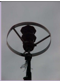
PARAFULMINE Foto di: ARPA Friuli Venezia Giulia Radionuclide: Am-241 Provenienza:
